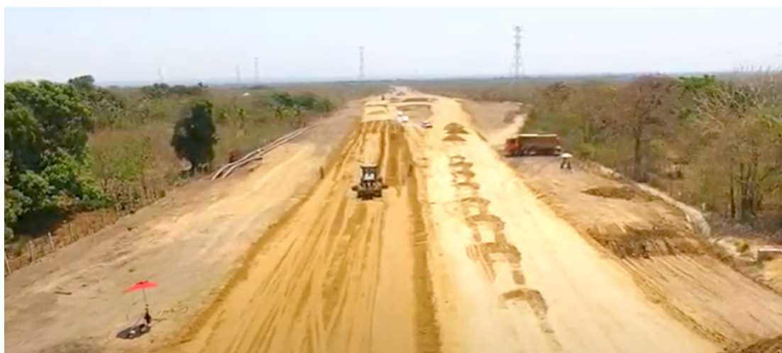
Figura 5. Circunvalar de la Prosperidad, Vía Barranquilla Cartagena. Fuente: Meco Constructora (2018).
