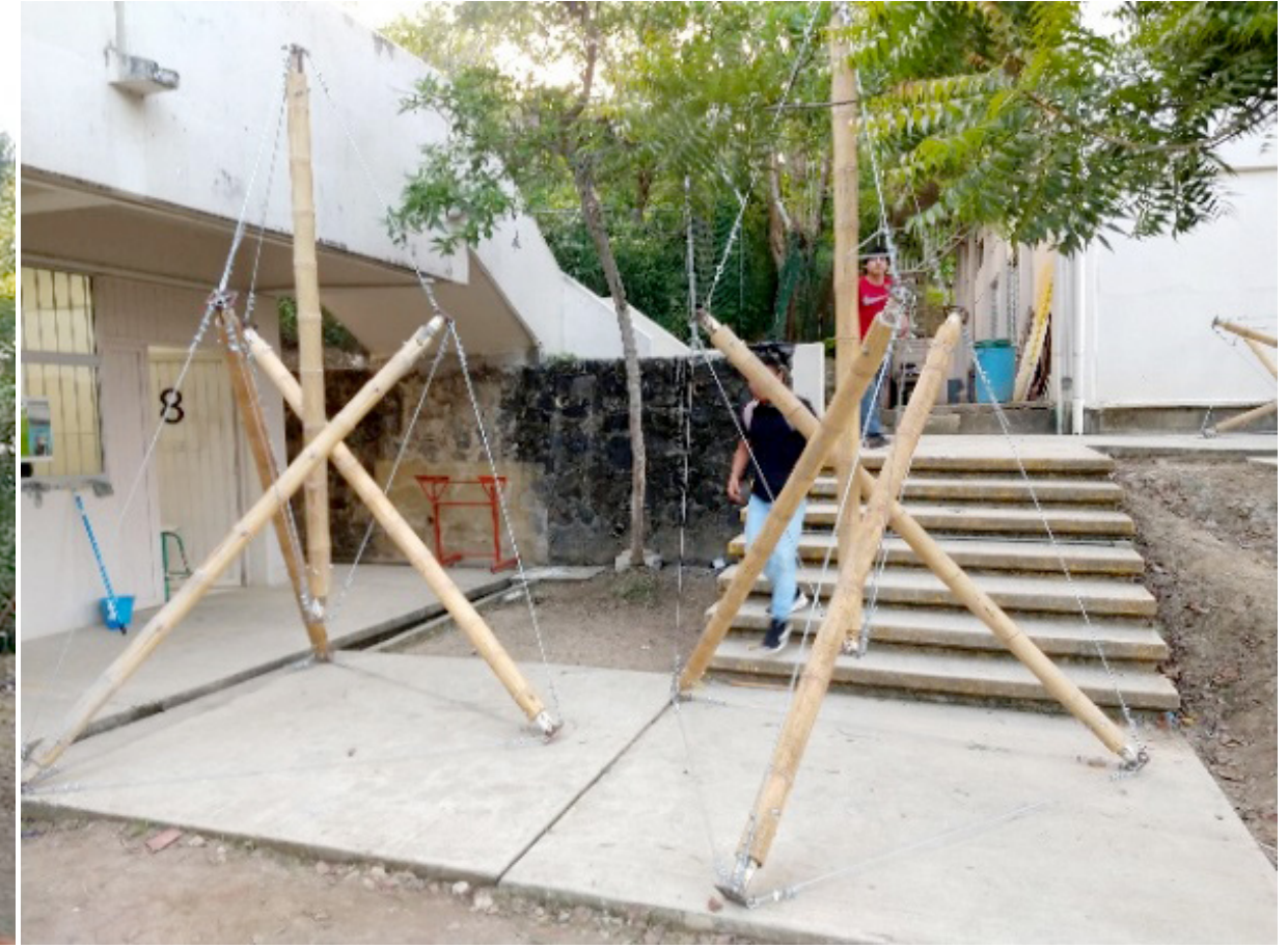
FIGURA 50. Armado de pilar terminado.
