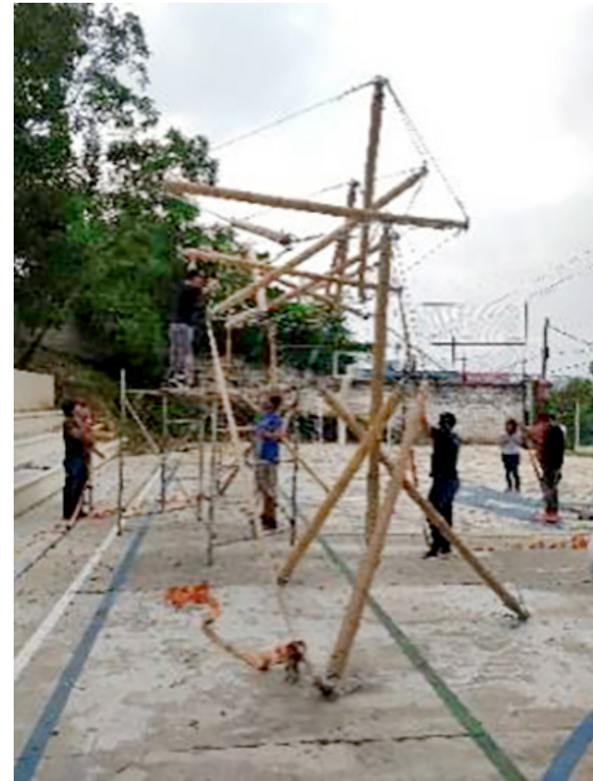
FIGURA 56. Estructura final armada.
