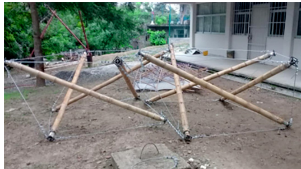
FIGURA 42. Armado terminado y prueba de carga empírica.
