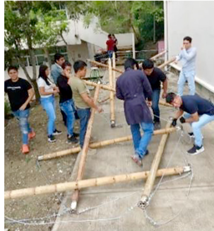
FIGURA 43. Armado de los módulos continuos y detalles de percance de uniones.
