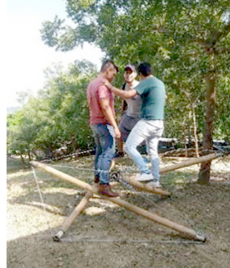
FIGURA 41. Armado terminado y prueba de carga empírica.
