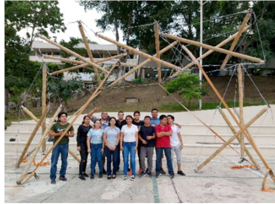
FIGURA 58. Estructura final armada.
