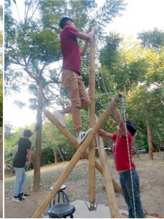
FIGURA 49. Armado de pilar terminado.
