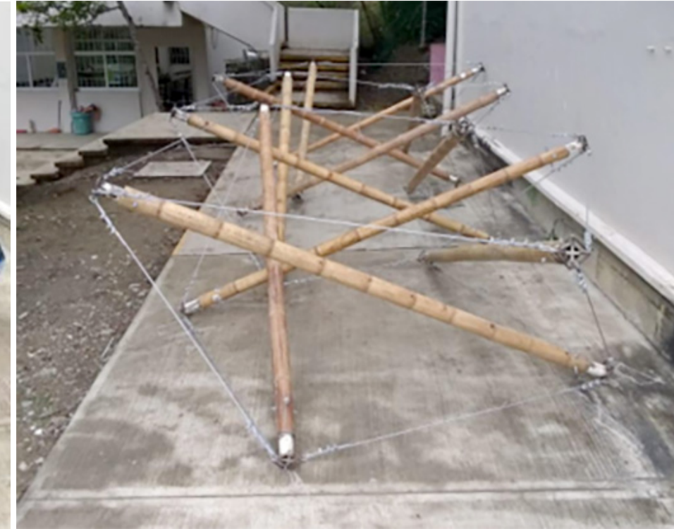
FIGURA 44. Armado de los módulos continuos y detalles de percance de uniones.
