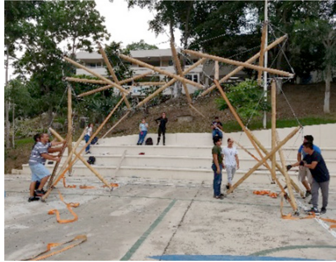
FIGURA 57. Estructura final armada.
