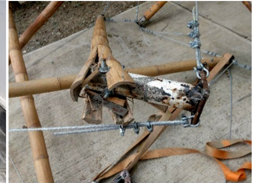
FIGURA 45. Armado de los módulos continuos y detalles de percance de uniones.
