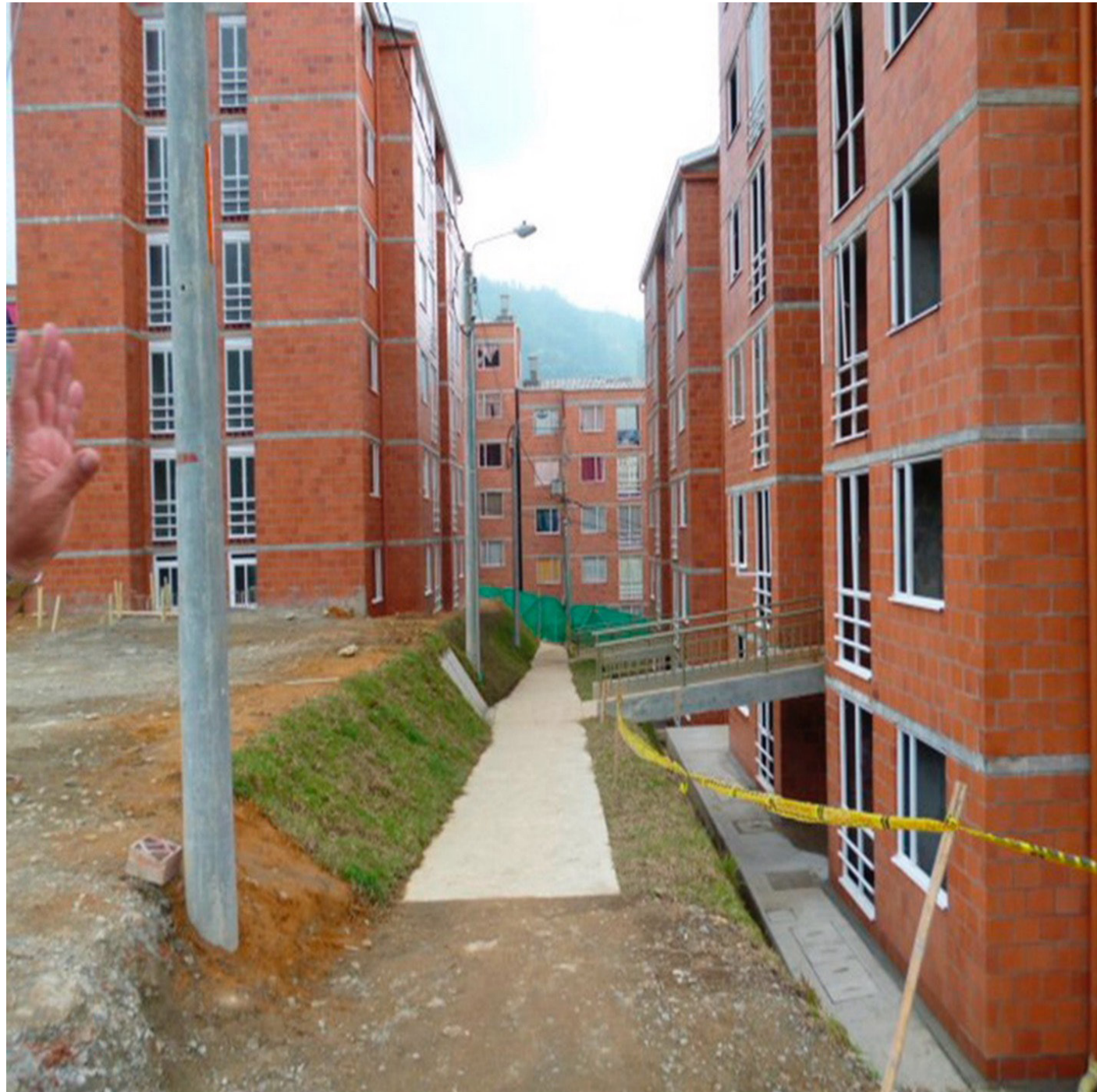
Figura 5. Espacio público del conjunto habitacional.
